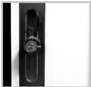
seřízení přítlaku na oknech - excentrický váleček
