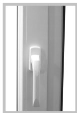
zavřeno křídlo je přitaženo k rámu pomocí západek po jeho obvodu
