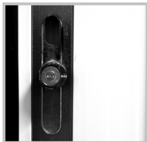
seřízení přitlaku na oknech - excentrický váleček
